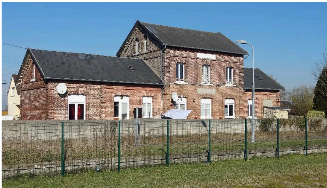
Vue générale de la façade sur voie.
