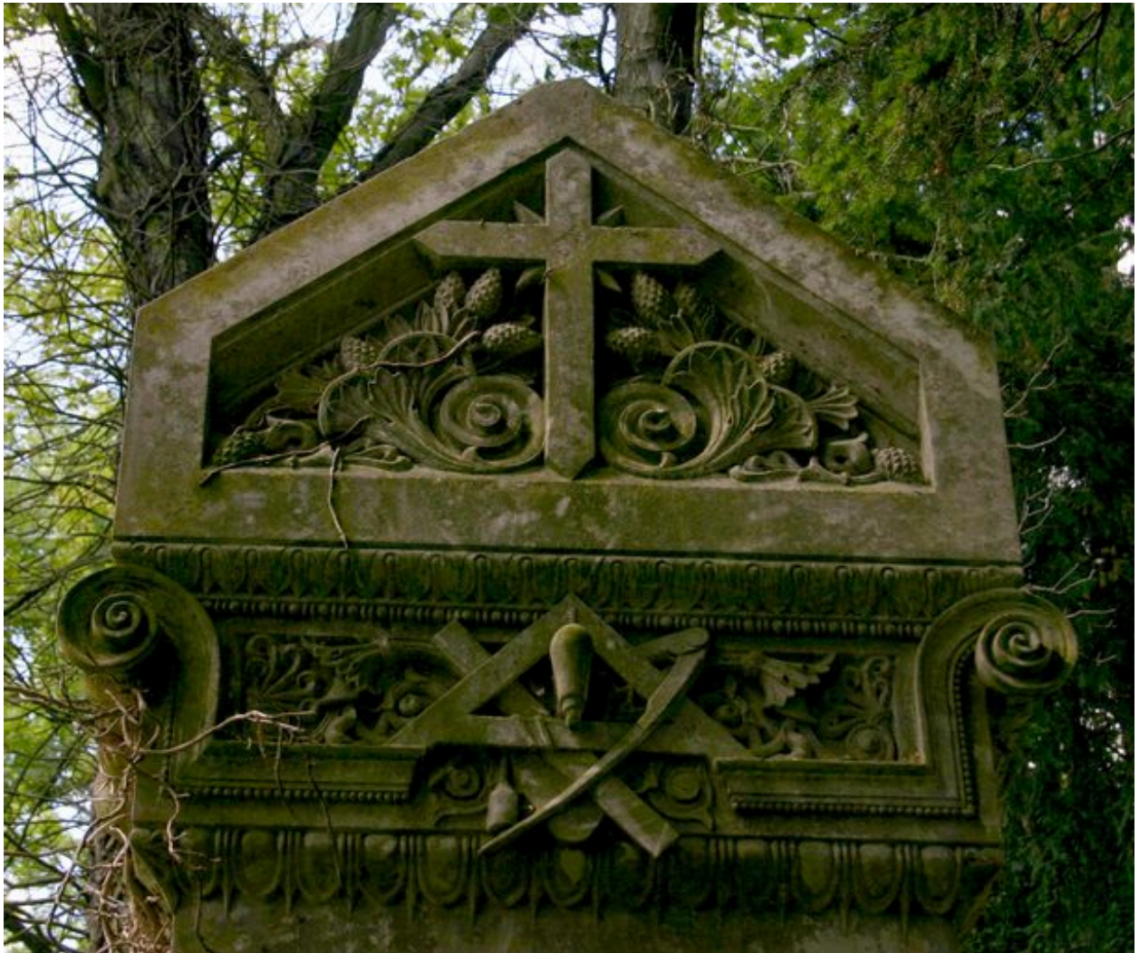
Tombeau de l'entrepreneur Leroy-Digeon, Edmond Duthoit (architecte), 1876 : détail du fronton sculpté.
