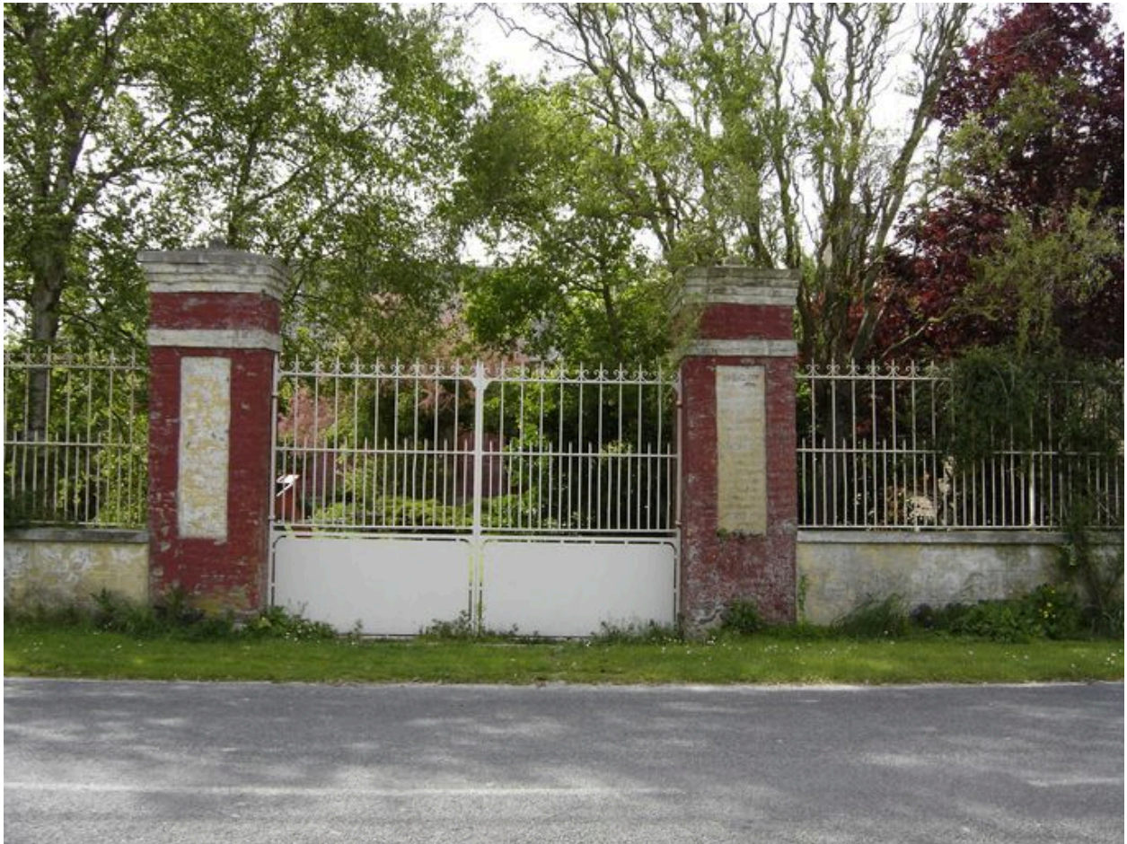
Vue de face de l'entrée.
