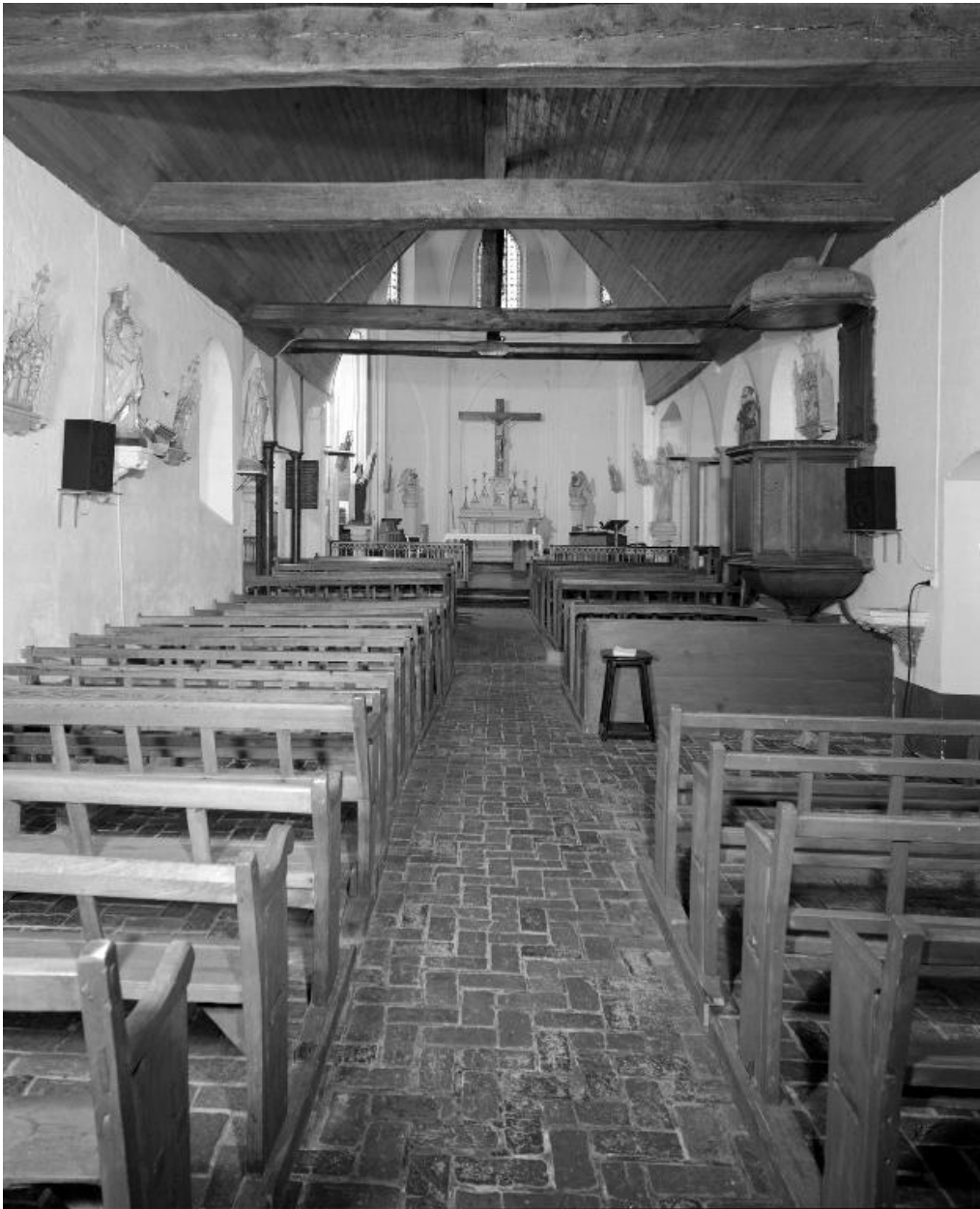
Vue intérieure de la nef, vers le choeur.
