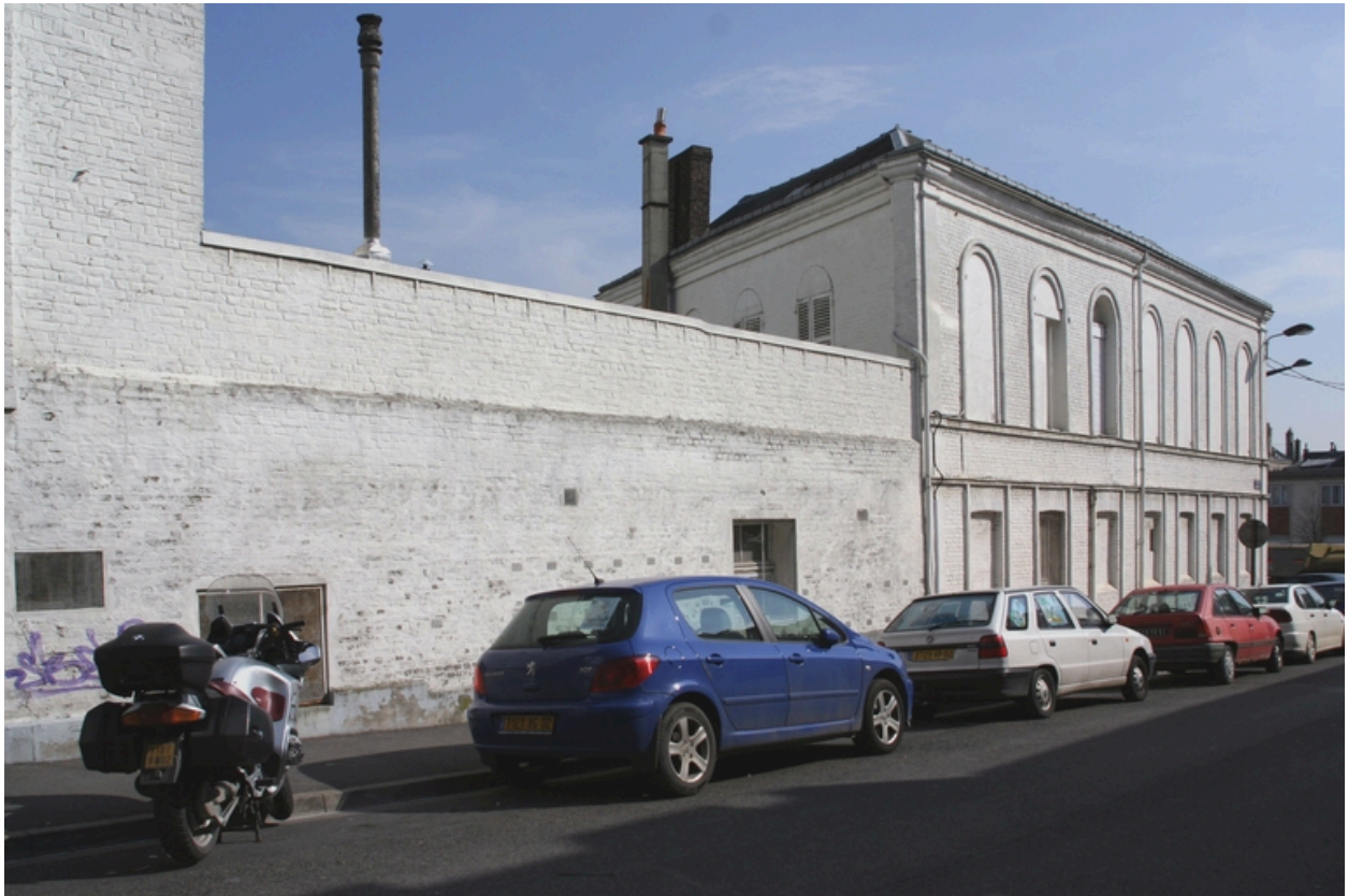
Façade postérieure, rue Michelet.
