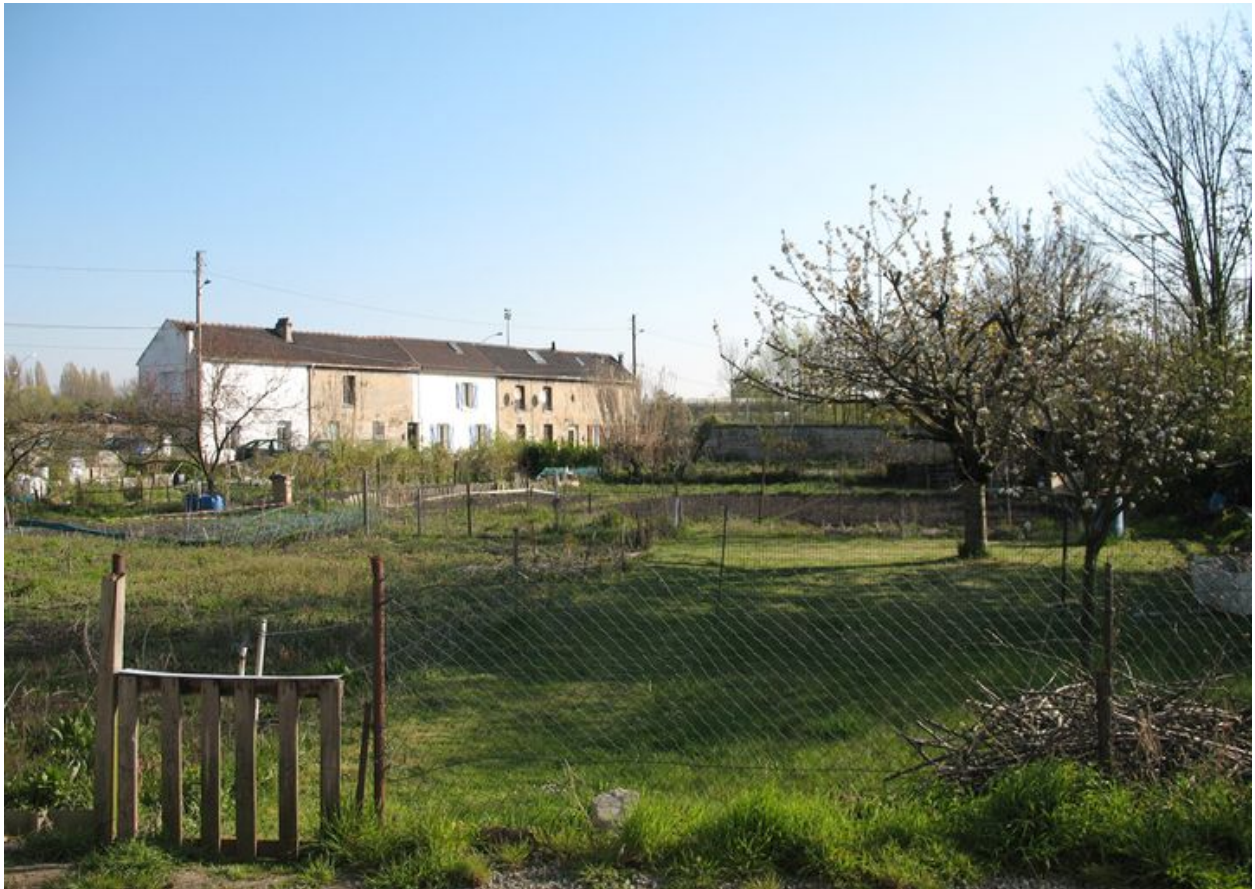
Barre de logements ouvriers construits en pierre.
