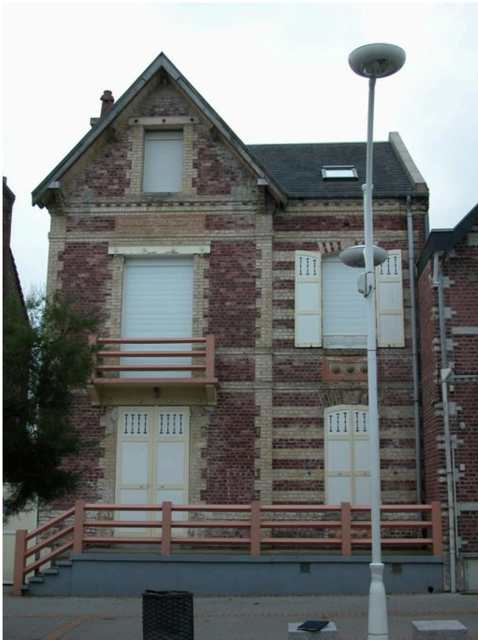
Appareil mixte de briques rouges et ocres (Chalet Benedict, 925 avenue de la Plage).
