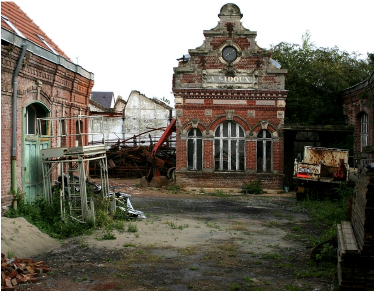
Façade des bureaux de l'usine.
