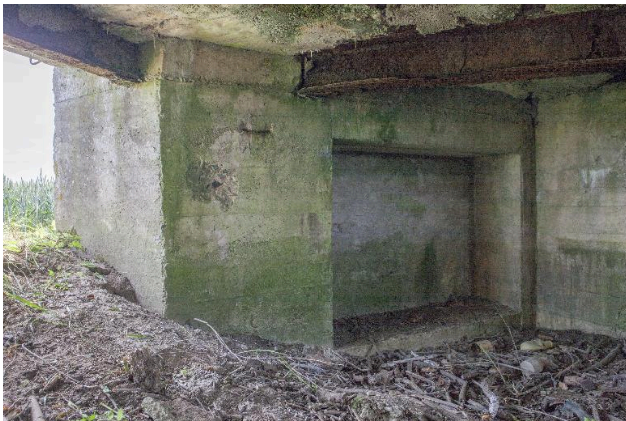
Chambre de tir, niche ouest
