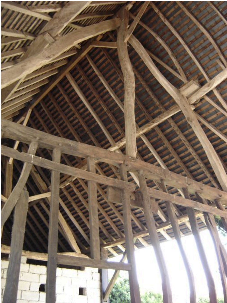
Vue de l'ossature en bois et de la ferme de la grange.
