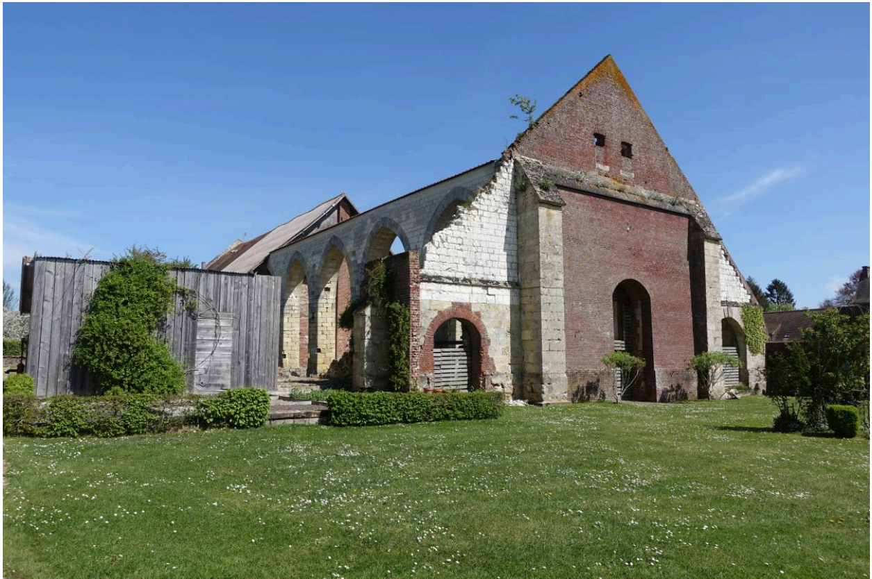
Vue générale de la grange médiévale depuis le nord-ouest.
