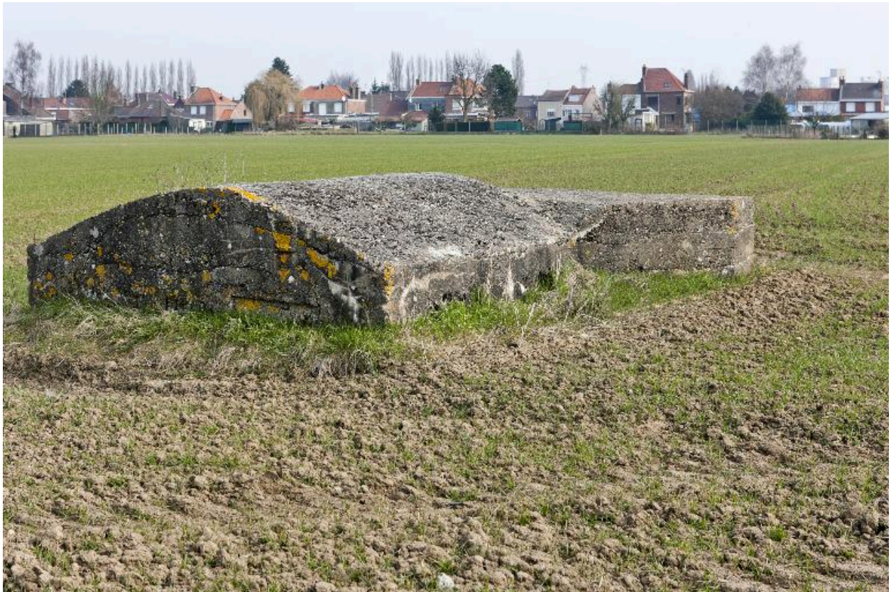
Vue vers le nord-est. Casemate a
