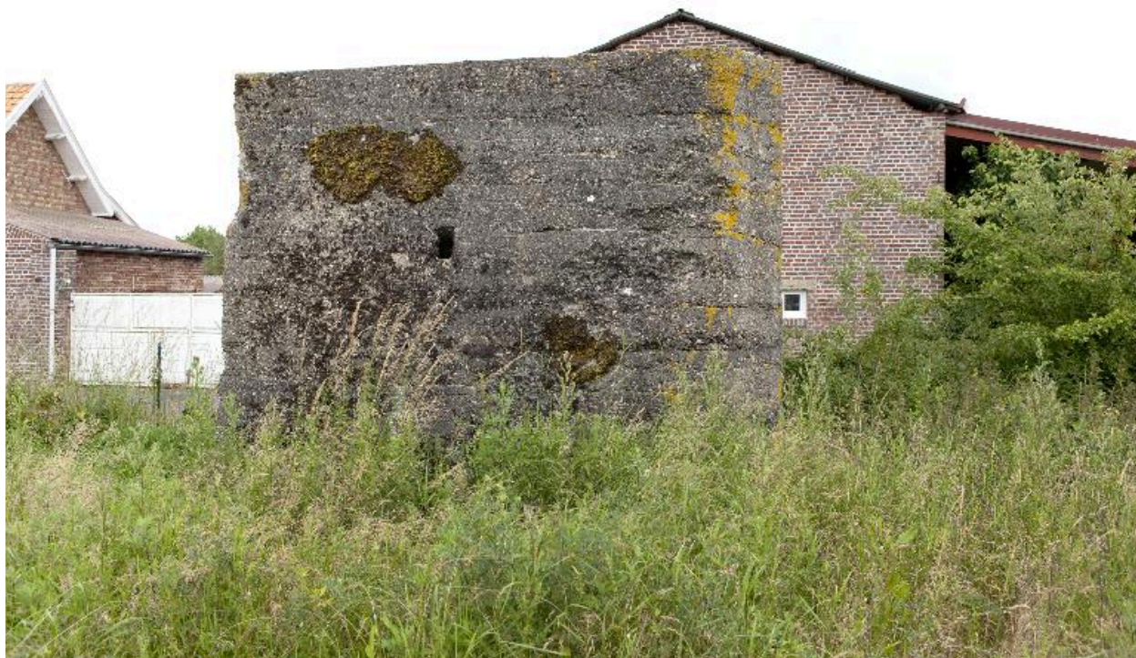
Guérite casematée (Bat. A). Elévation ouest
