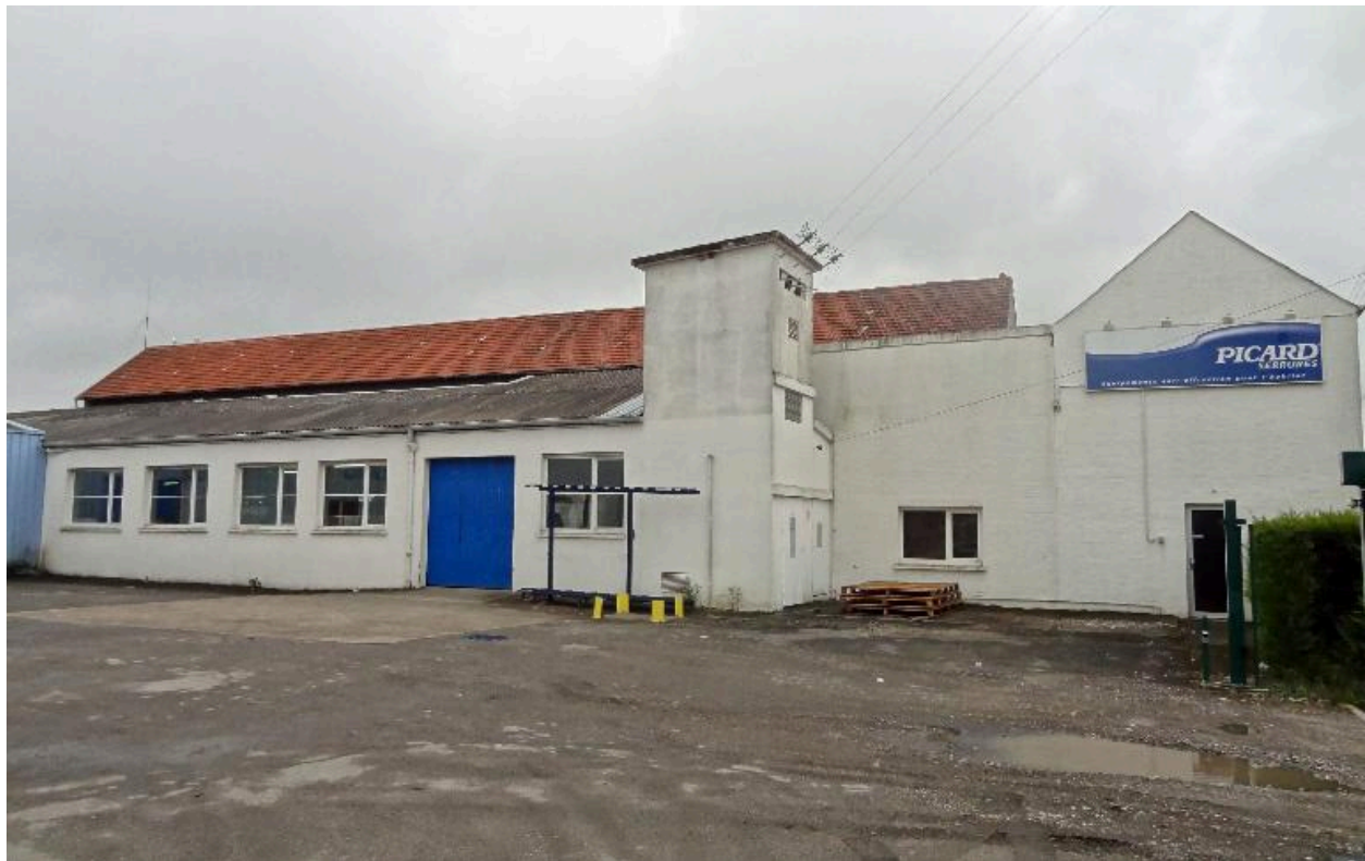
Vue générale des premiers bâtiments de l'usine.
