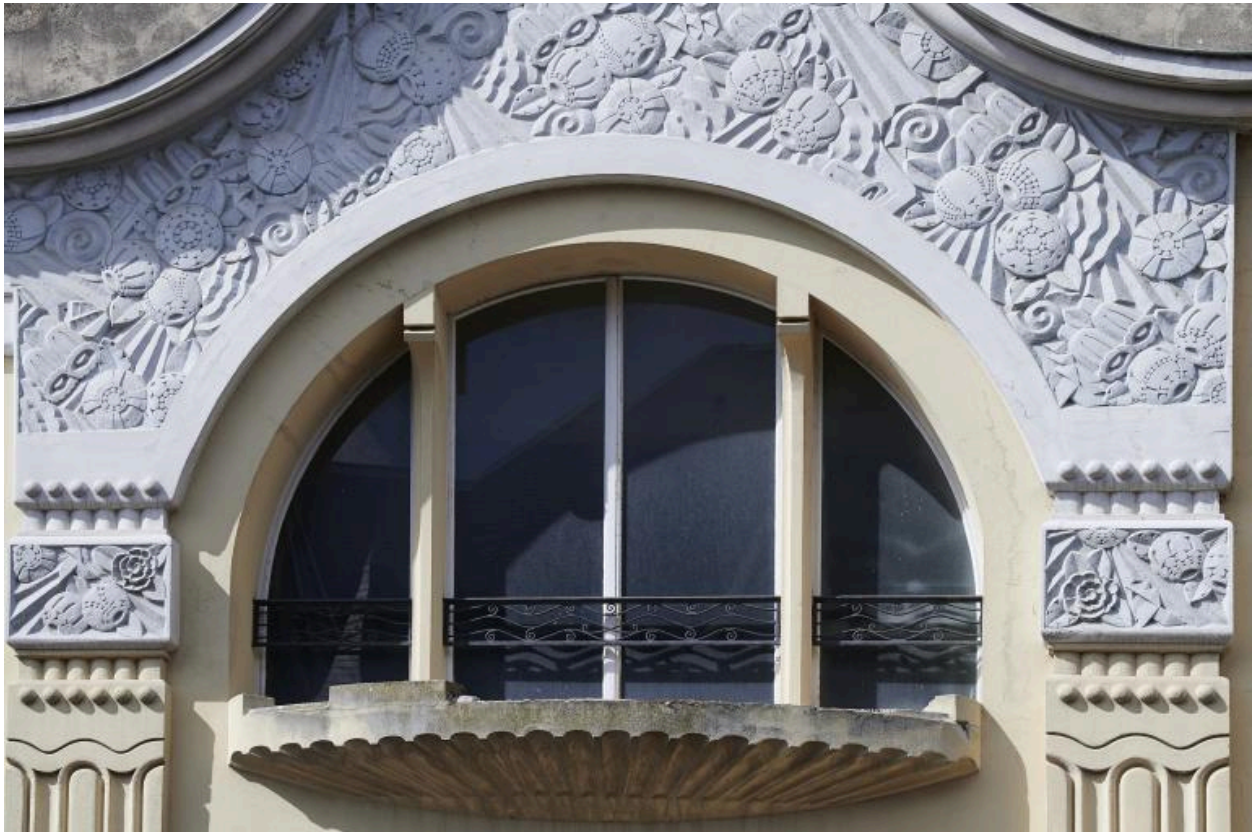
Façade principale, détail d'une des baies thermales et son décor floral stylisé.
