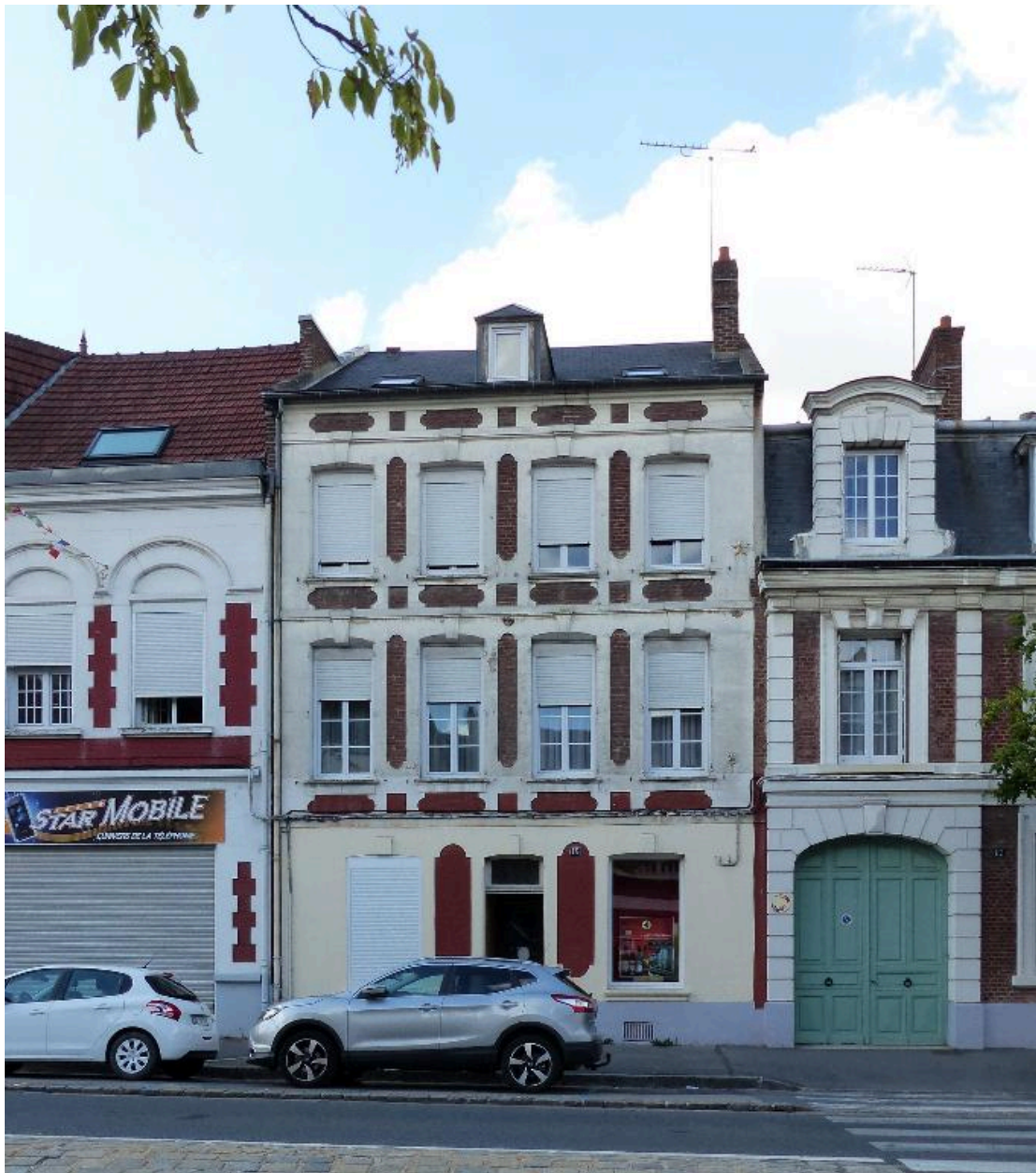
Maison, 15 rue Saint-Sauveur (B 333), reconstruite vers 1921.
