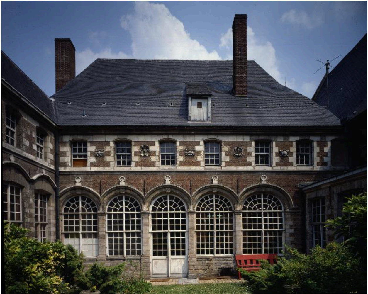
Bâtiment bordant le côté est de la cour d'honneur, élévation sur la cour.
