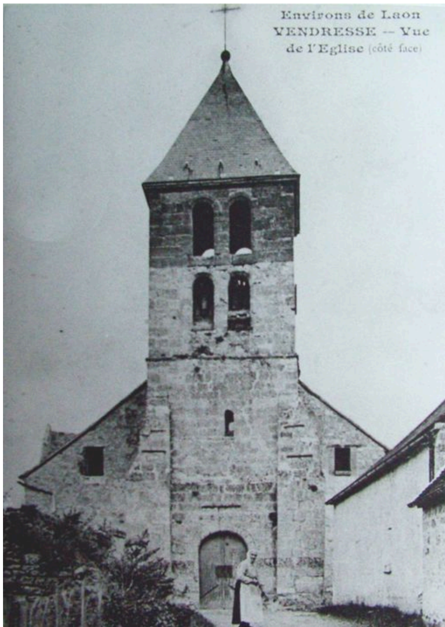
Vue de la façade de l'ancien édifice (coll. part).
