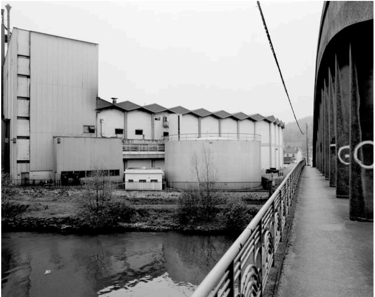
Ateliers de fabrication : vue partielle.
