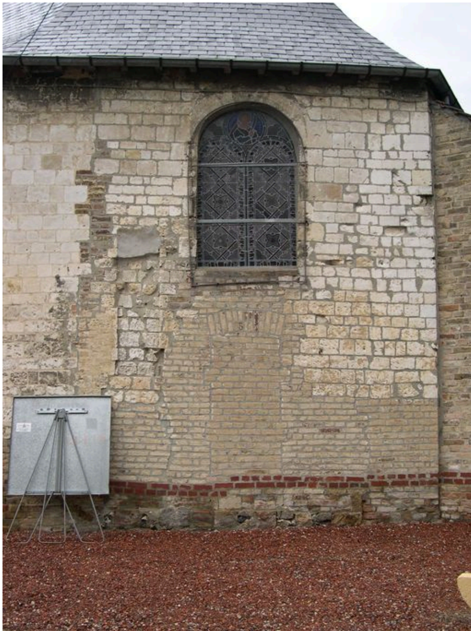
Détail du mur sud du choeur.
