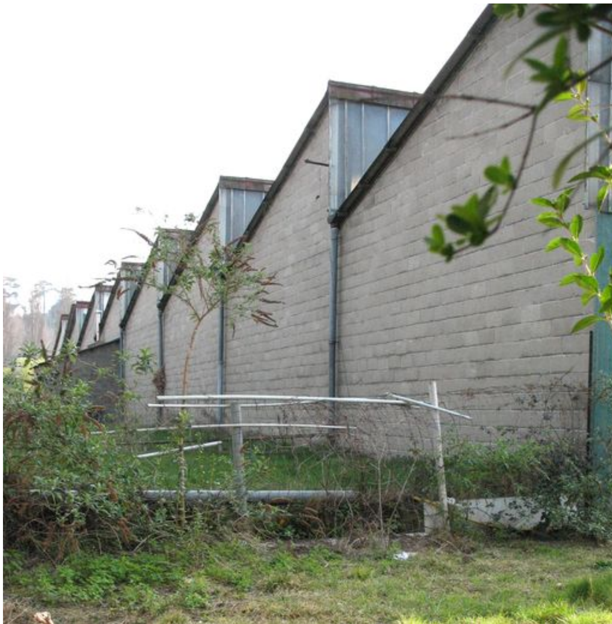
Vue vers le sud des ateliers de fabrication.
