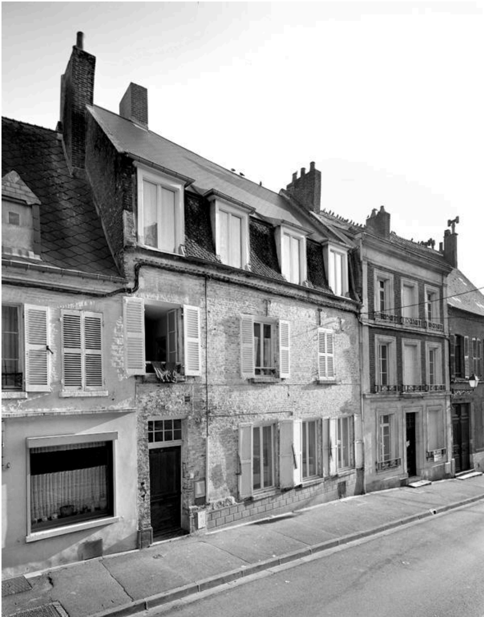
Vue de la façade sur rue.
