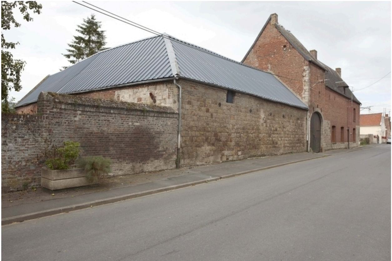
Vue générale de l'élévation sur rue depuis le sud-est.
