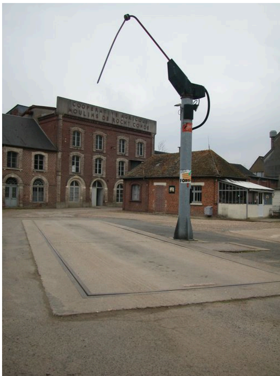
Vue d'ensemble de la minoterie sur cour.
