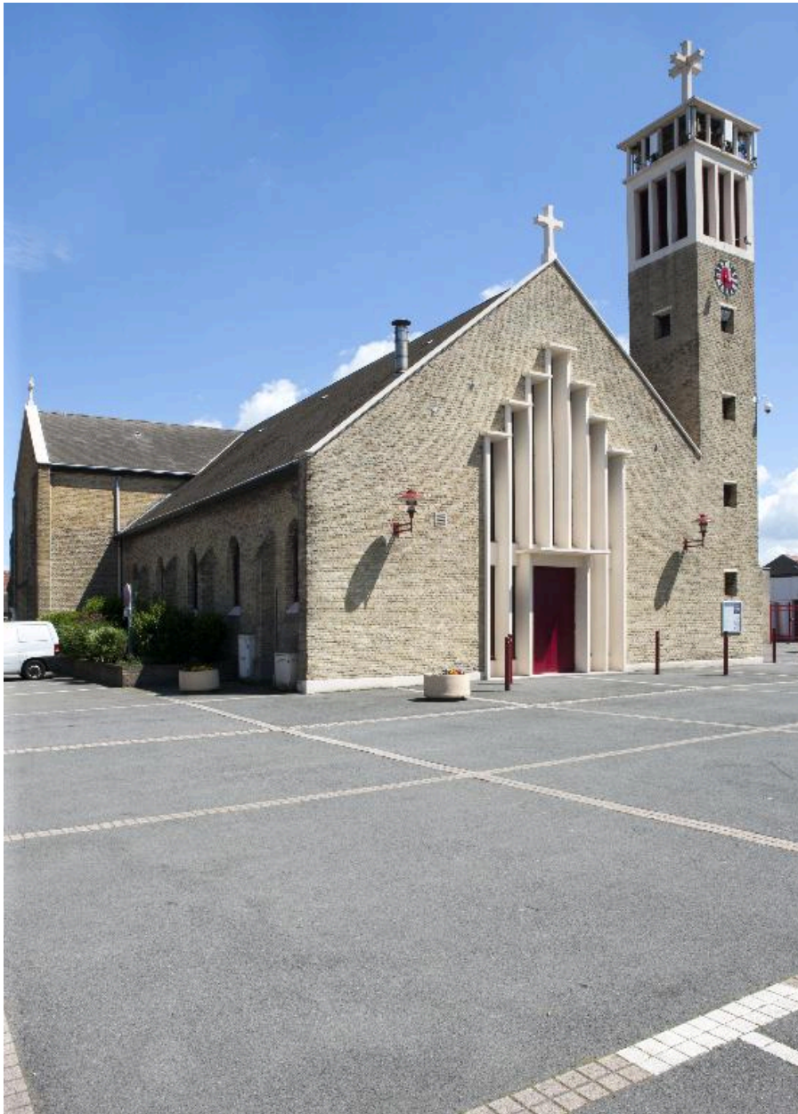
Vue de trois-quart de l'élévation antérieure de l'église.
