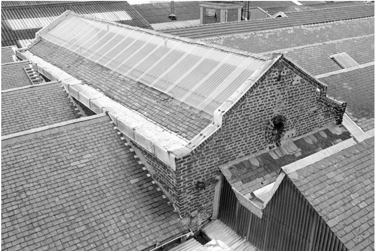
Atelier de fabrication, en 1990.
