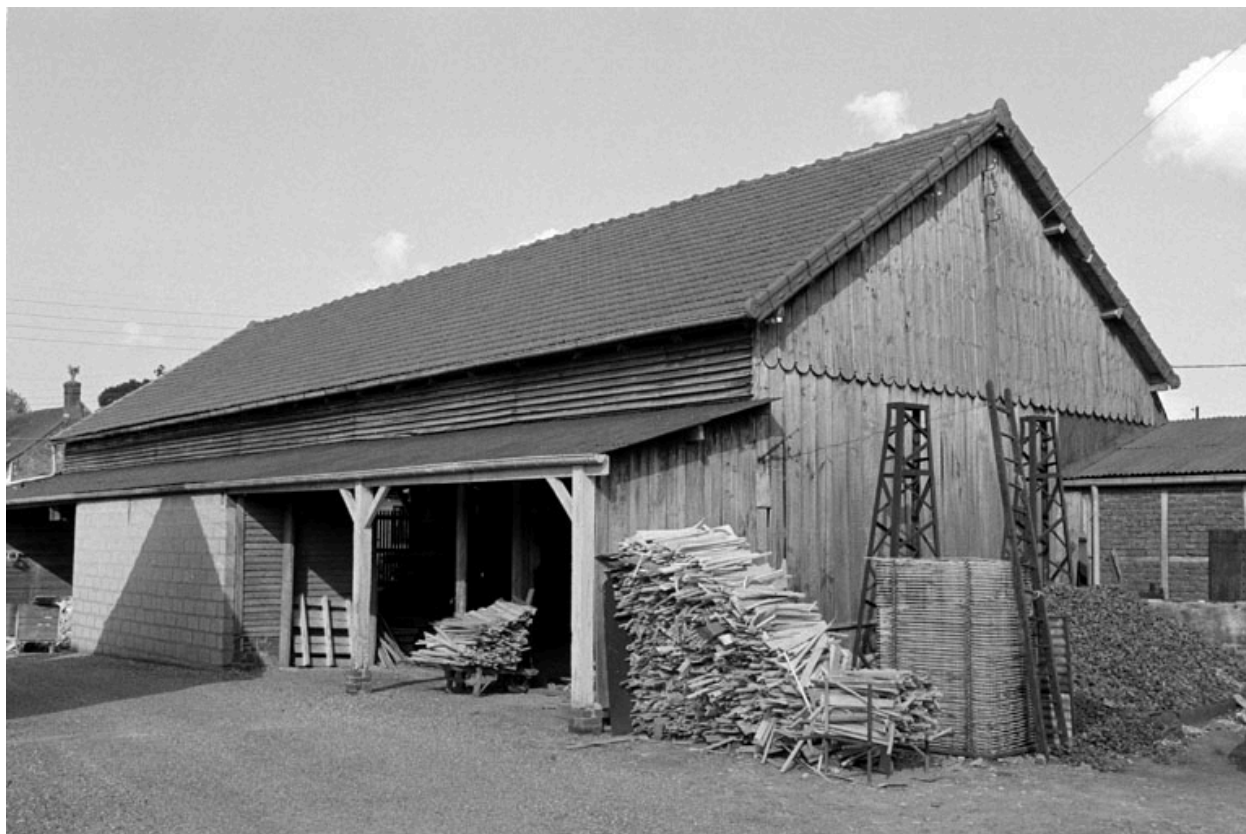
Entrepôt en bois, en 1990.
