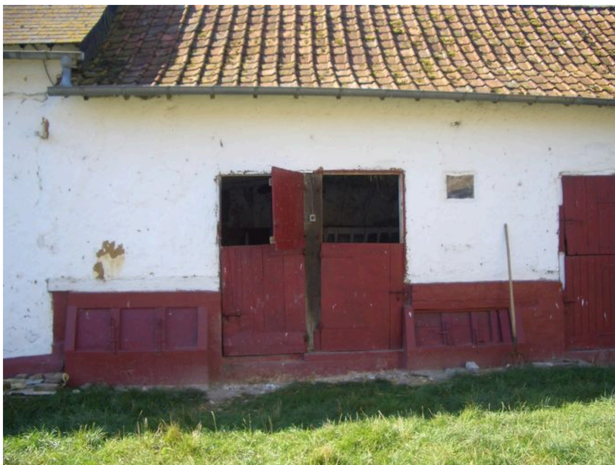
Vue des portes des étables avec système d'alimentation des auges extérieur.
