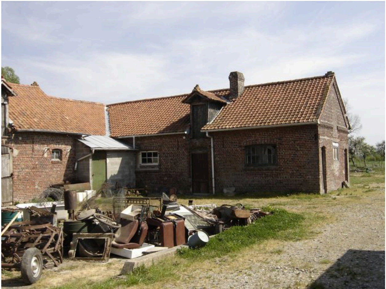
Vue des étables au sud-est de cour.
