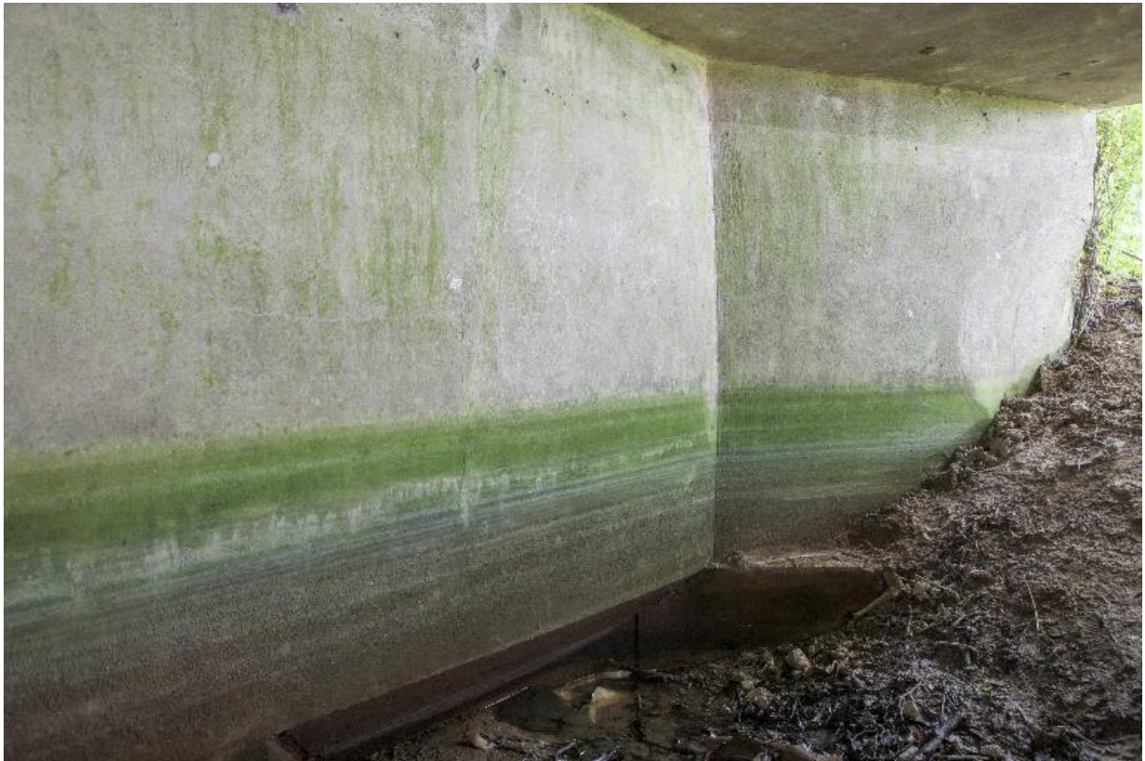
Chambre de tir. vers l'ouest.
