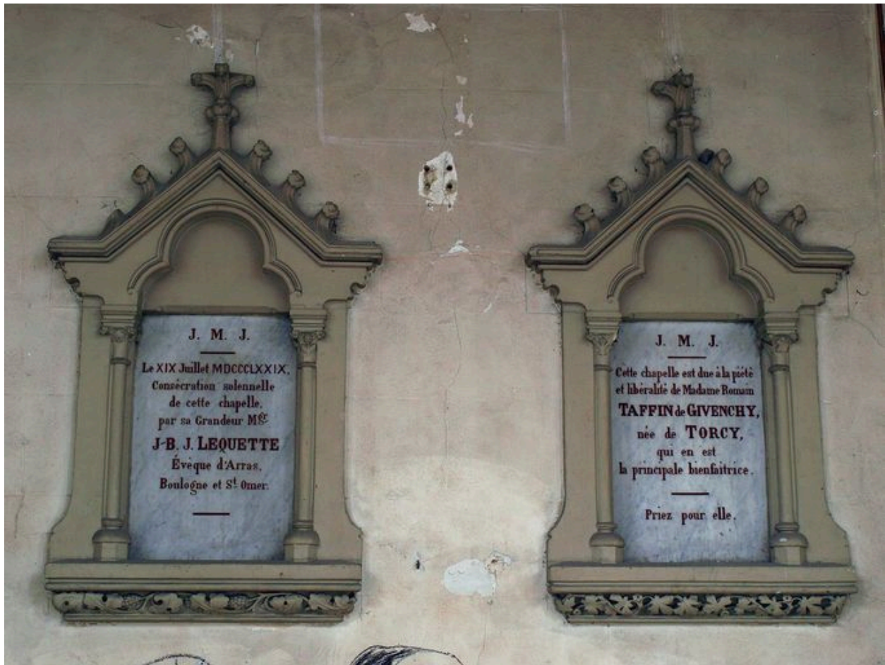
Chapelle, intérieur : vue générale des deux plaques.
