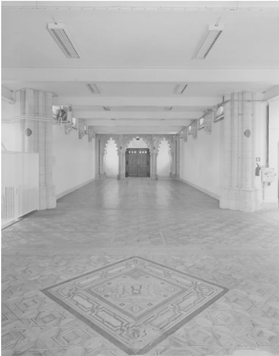
Vue intérieure vers l'entrée, partie basse.
