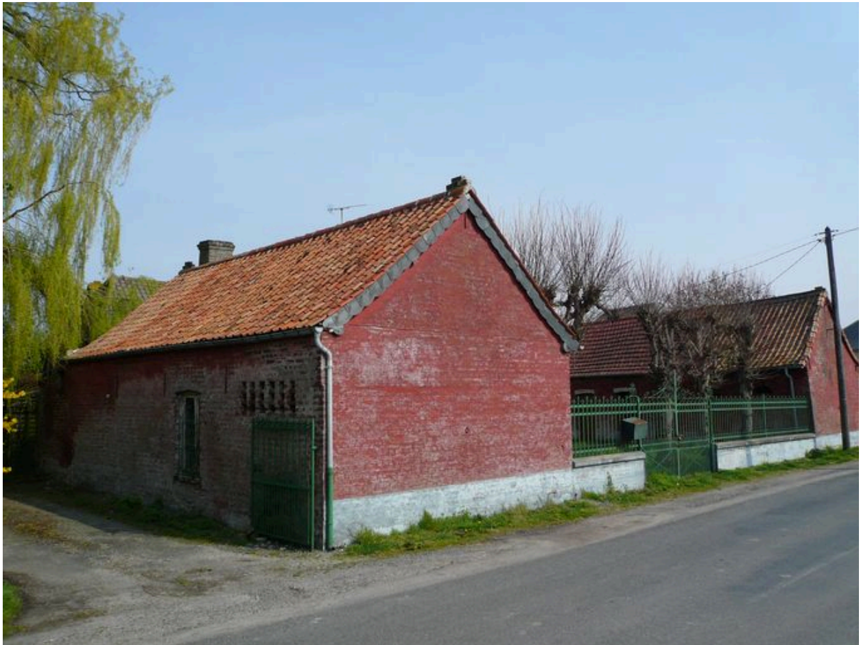
Vue générale depuis l'ouest.
