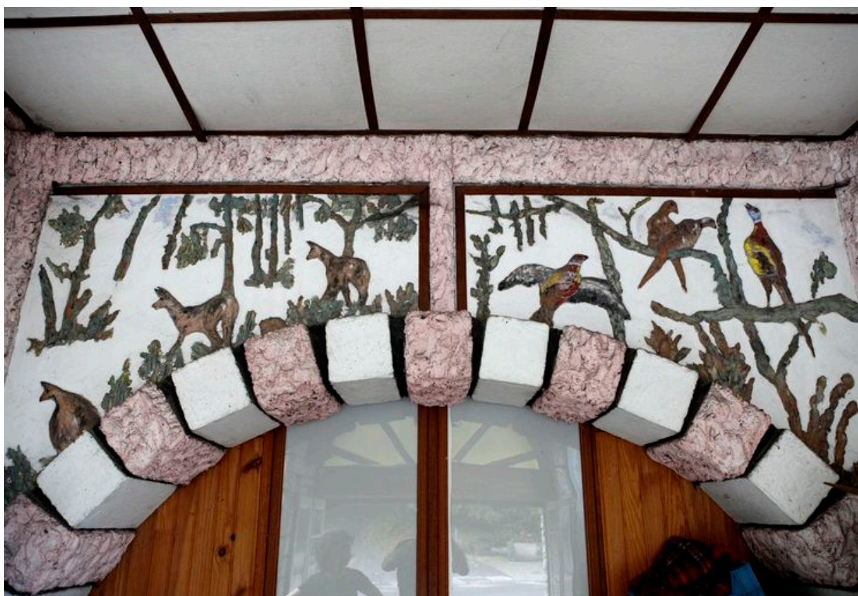
Vue intérieure du garage : voûte et extrados de voûte décorés.
