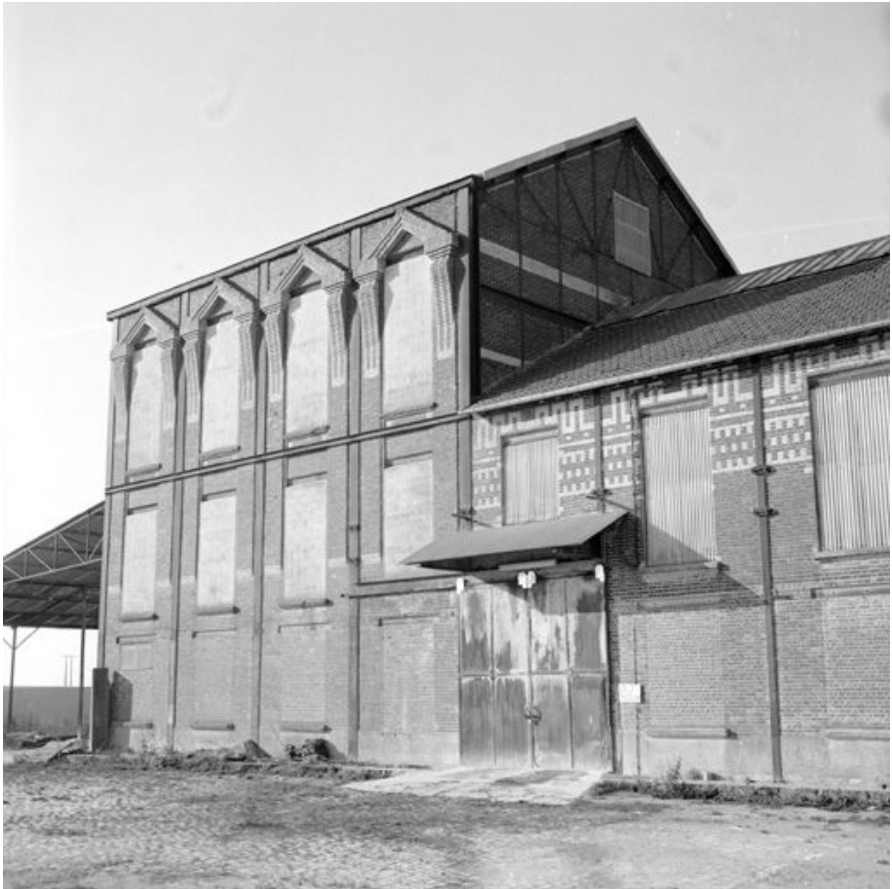
Atelier principal, flanc est. Détail.
