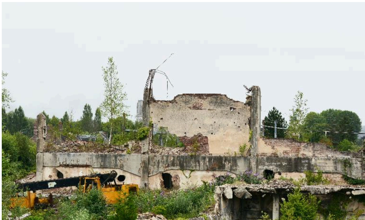
Vestiges de la centrale électrique depuis le sud-est en juillet 2015.
