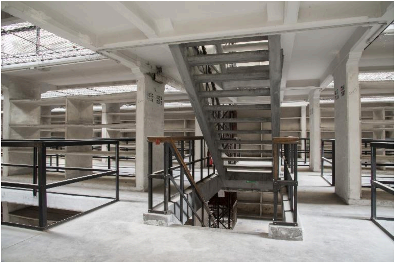
Bâtiment du dépôt, premier étage : vue de l'escalier depuis le vaisseau 3.
