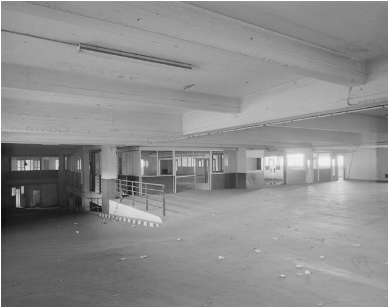
Vue d'ensemble de l'entresol et des bureaux de comptabilité.
