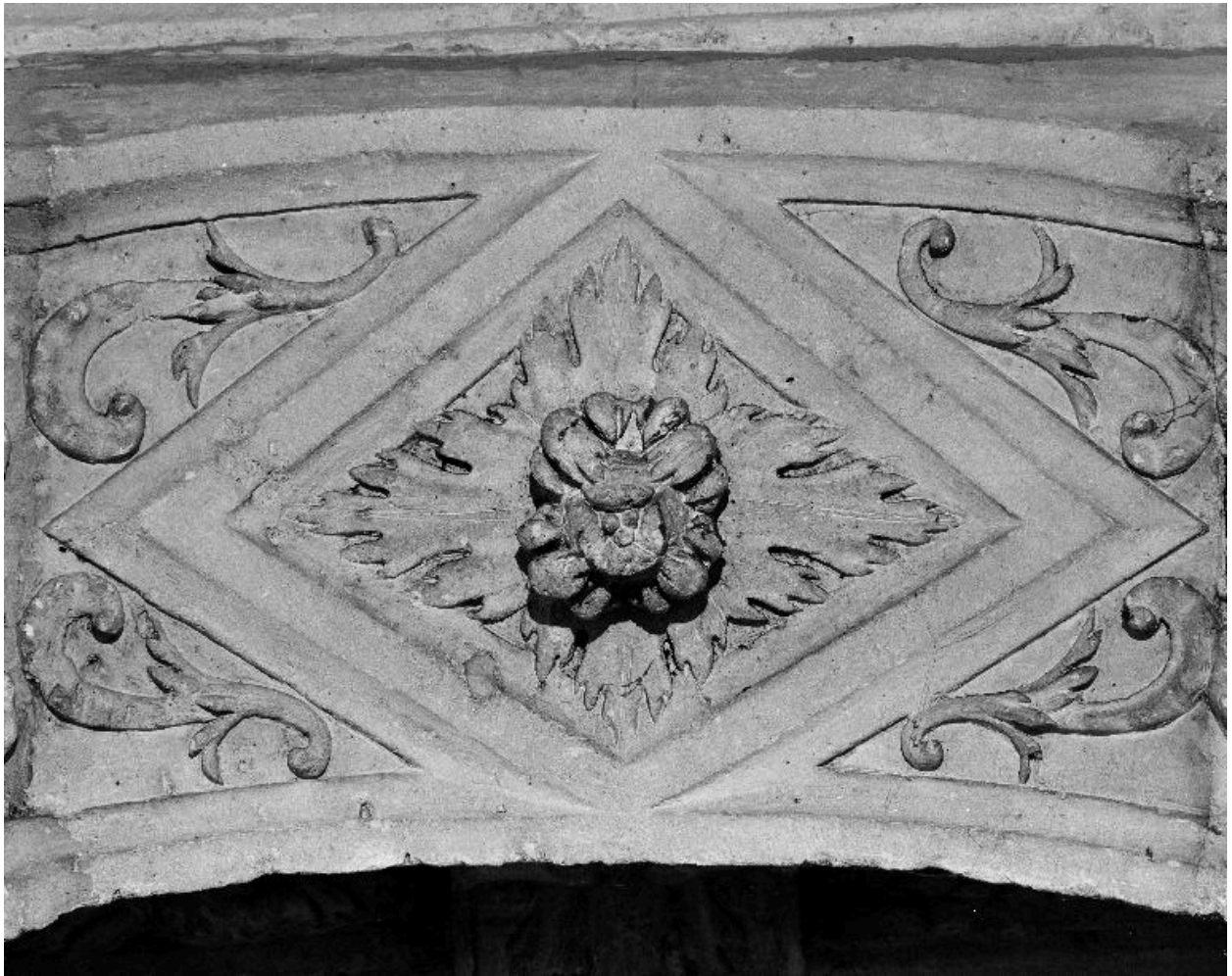
Détail du décor de l'intrados d'un arc diaphragme.
