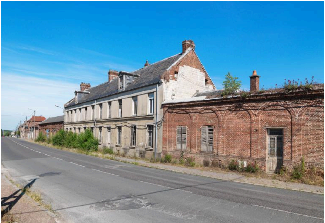
Vue des façades sur la route d'Amiens.
