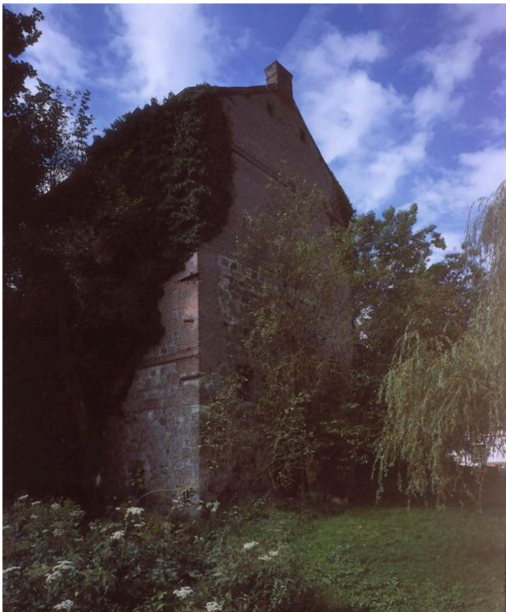
Pignon sur cour du moulin, vue d'ensemble.
