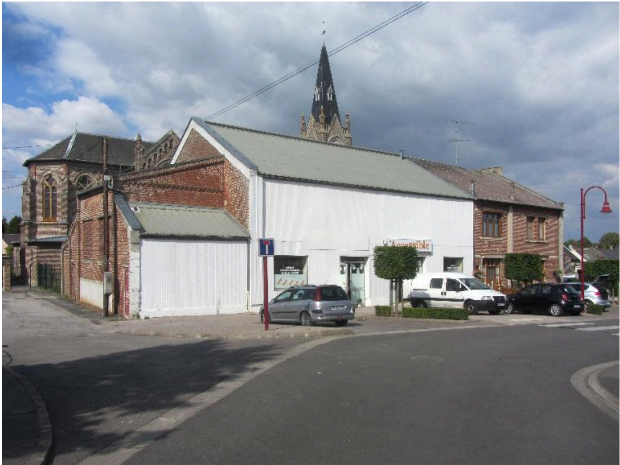
Vue générale depuis le sud-ouest.
