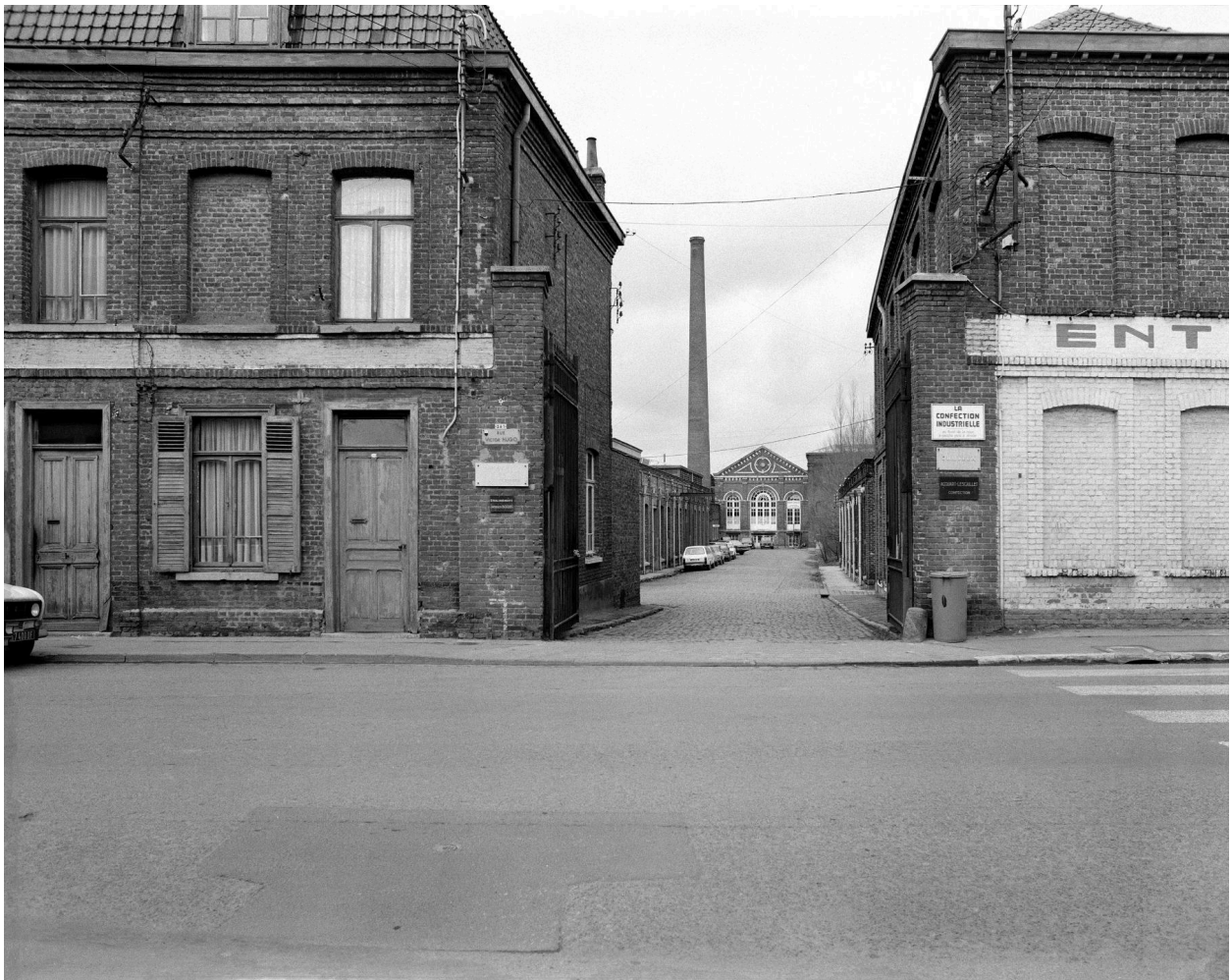
Vue générale depuis la rue. Vue prise vers le nord.
