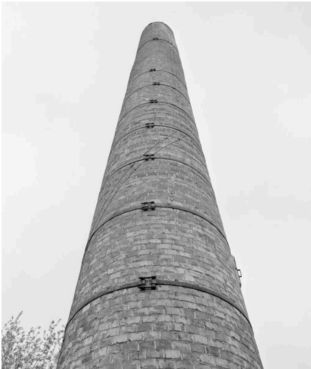
La cheminée d'usine.
