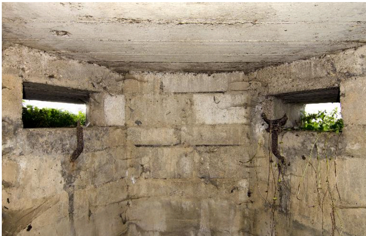
Vue intérieure de la tourelle sud
