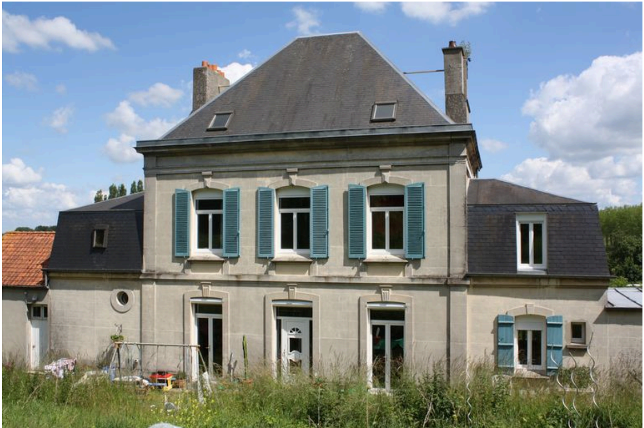
Elévation postérieure, sur jardin.
