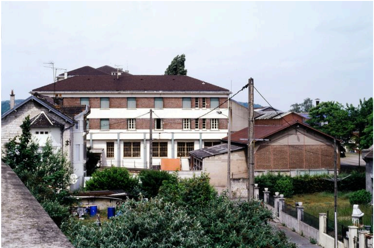
Vue du lycée Gournay depuis le pont Y. Au premier plan, les jardins et la cité ouvrière cheminote (détruits).
