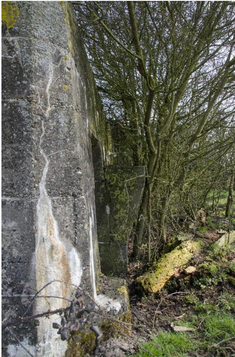
Profil taluté de l'élévation sud. A gauche l'entrée ouest, au centre, la banquette de tir
