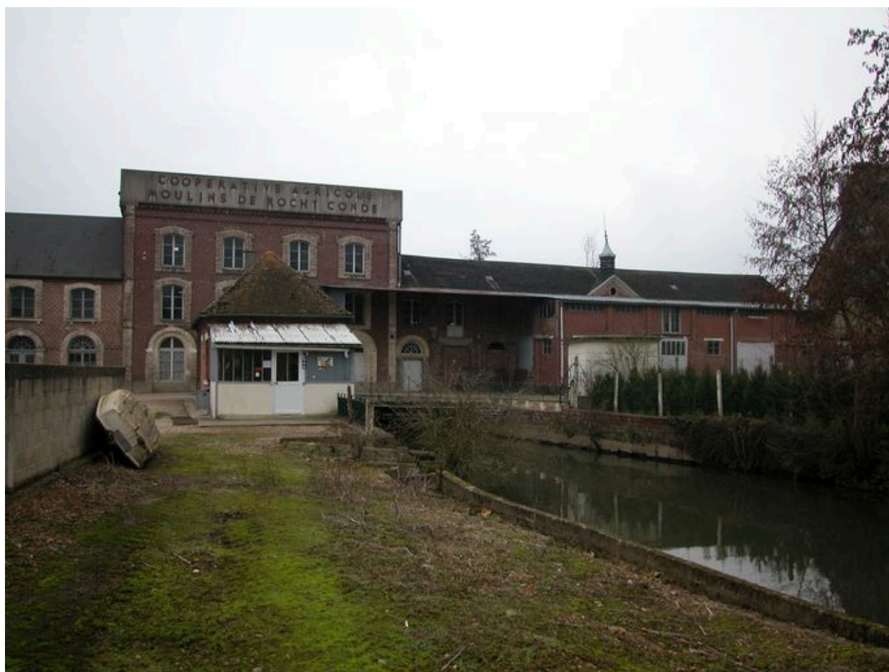
Vue d'ensemble de la minoterie et de l'entrepôt à grains depuis le Thérain.
