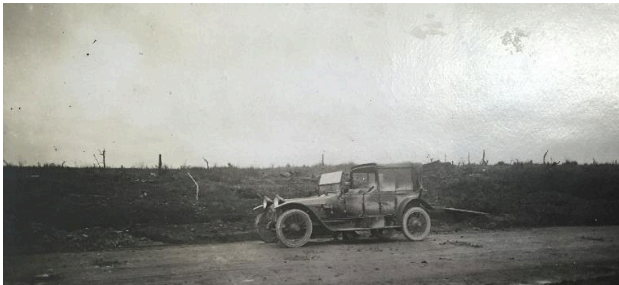
Vue de l'emplacement de l'usine, 5 décembre 1918 (AD Somme ; 10 R 343).
